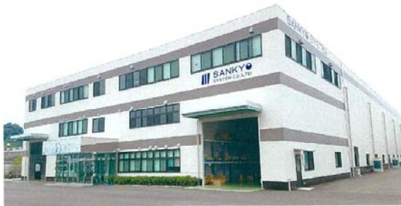
最新鋭設備を備える本社及び工場(平成28年移転)。
